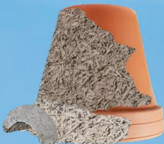
**3 Moules :** Paver le béton de bois autour des moules et bien le presser. Recouvrir les moules de film plastique pour empêcher qu'ils sèchent.
