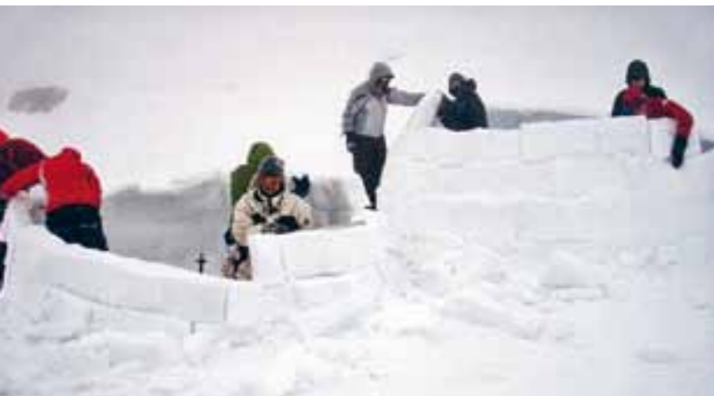
Block für Block muss exakt spiralförmig aufgeschichtet werden.
